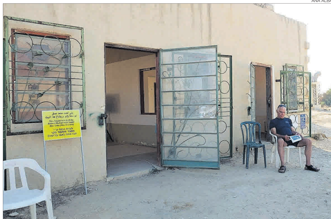
►► El recuerdo ► Un vecino, junto al único edificio que queda en pie del antiguo pueblo de Al Main.
