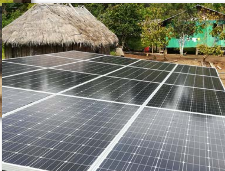
Projecte 3037. Consolidació de l'àrea d'energies renovables per la província amazònica de Pastaza (Equador). Associació Catalana d'Enginyeria sense Fronteres
